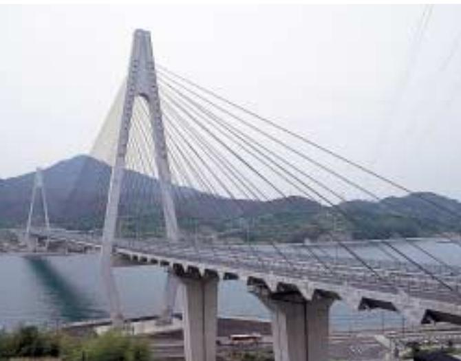
生口橋(広島県) / 橋長 790m / 主径間長 490m / 型式 斜張橋
