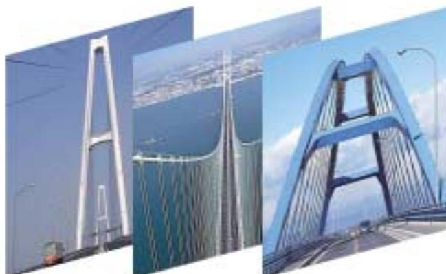
関門橋・瀬戸大橋をはじめ明石海峡大橋にいたるまで、多くの実績を重ねてきたTSK橋梁用ケーブル。その最高レベルの技術・品質・精度は国内だけでなく、海外からも高い評価をいただいています。当社では、橋梁用ケーブルとしてNEW-PWS、PWS、スパイラルロープ、ロックドコイルロープ、ストランドロープと豊富な種類を用意。中規模の橋から長大橋まで、さまざまな橋に対応しています。橋は永久構造物です。主部材であるケーブルは信頼性の高い当社ケーブルをお選びください。
