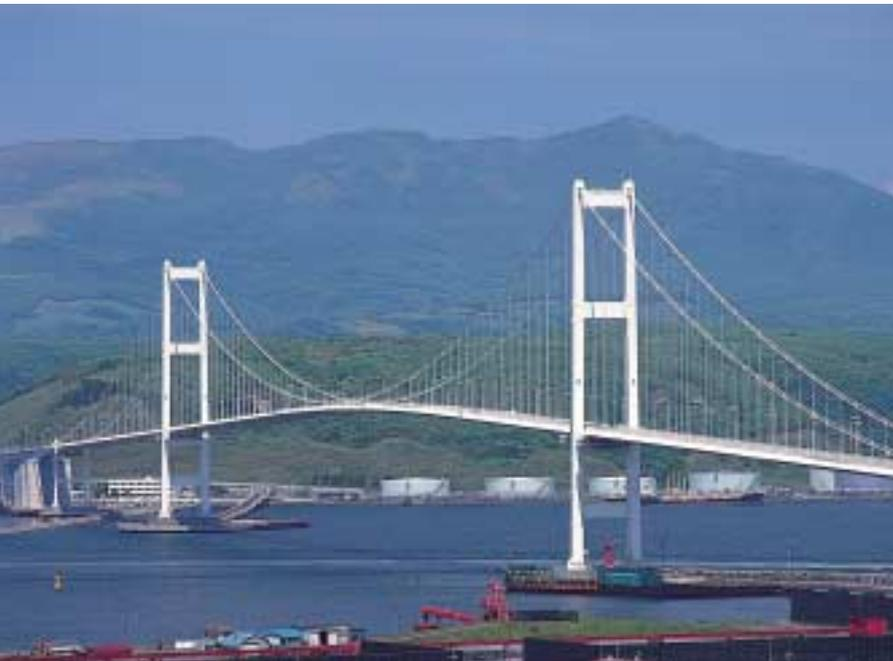
白鳥大橋(北海道) / 橋長1,380m / 主径間長720m / 型式 吊橋
