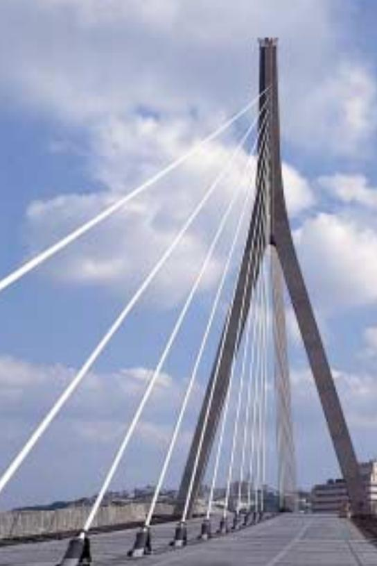
とよみ橋(沖縄県)/橋長299m/型式 斜張橋
