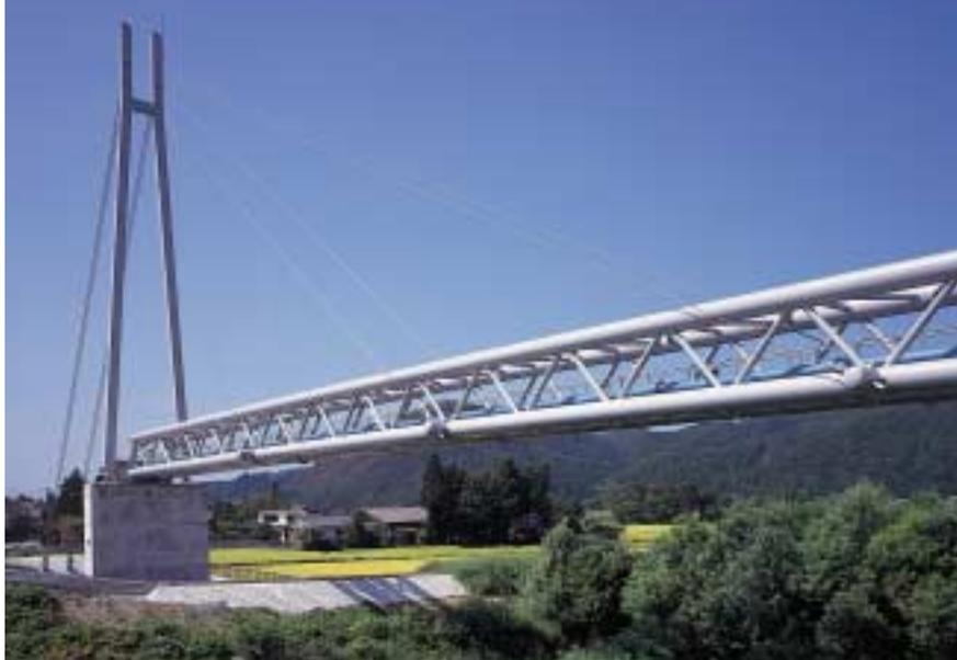
蔵光水管橋(新潟県)/橋長80m/型式 斜張橋
