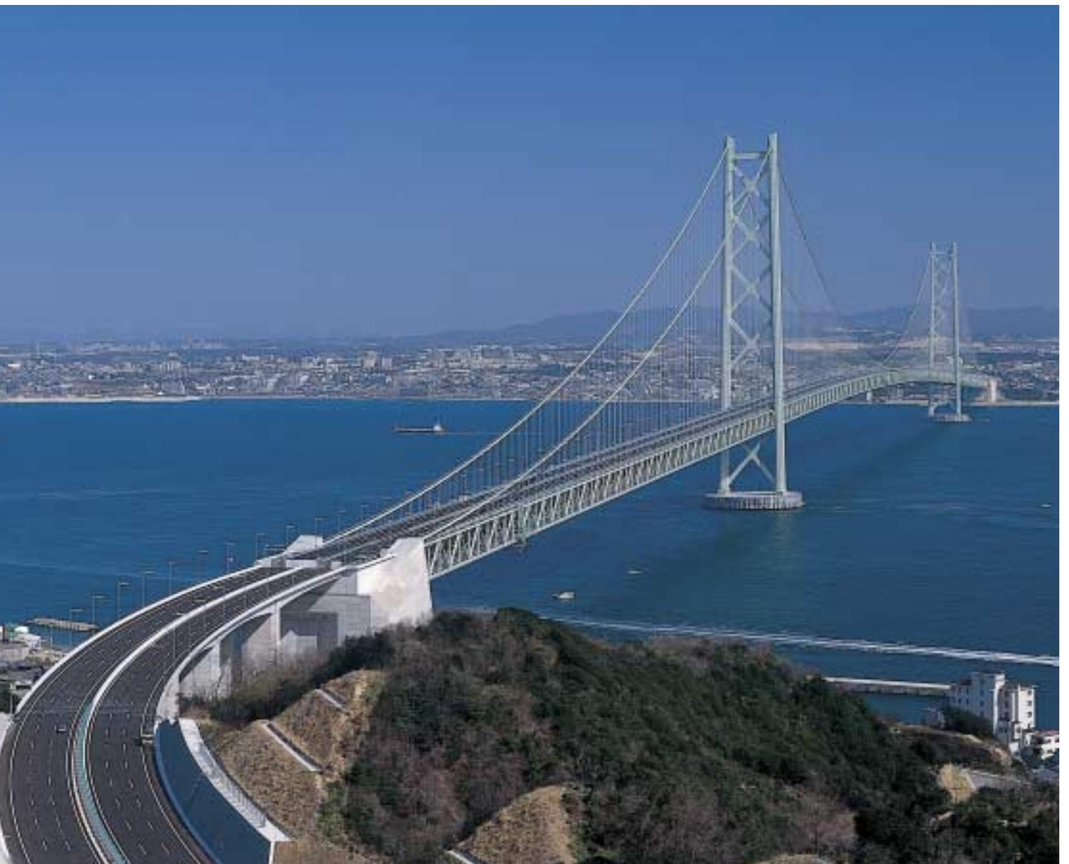
明石海峡大橋(兵庫県)/橋長3,910m/主径間長1,990m/型式 吊橋
