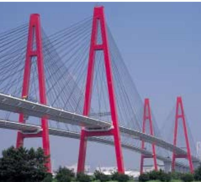
鶴見つばさ橋(神奈川県) / 橋長 1,020m / 主径間長 510m / 型式 斜張橋
